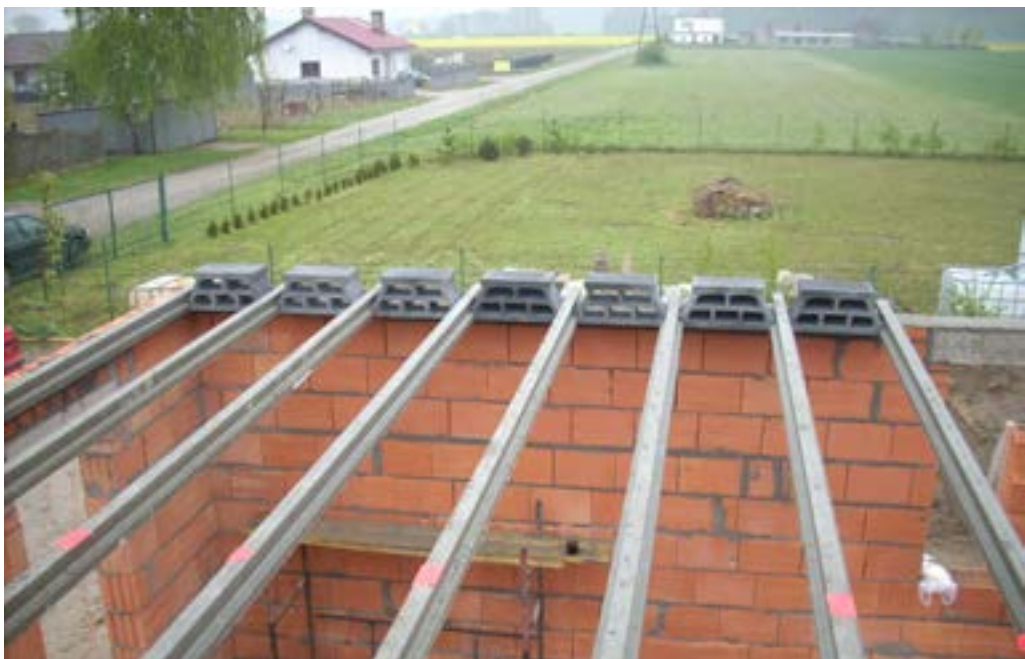
Fot. 1 Układanie belek na ścianach
