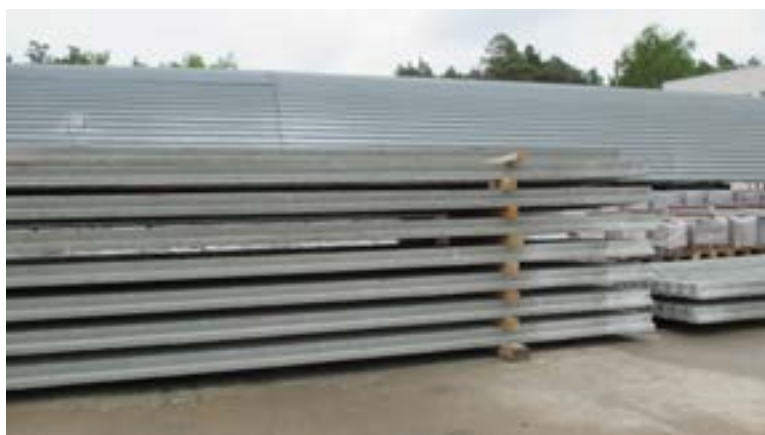
Fot. 3 Prawidłowe magazynowanie belek stropowych MASTER
